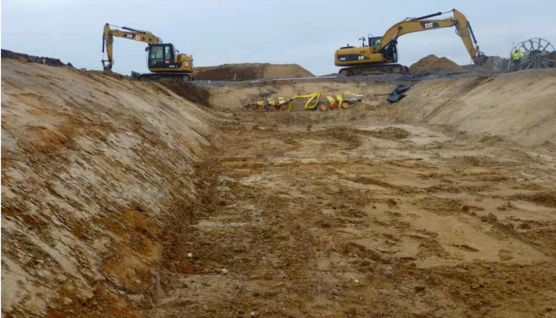
**Baugrube Muffenbauwerk 380 KV-Leitung Raesfeld**
